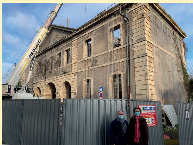
Démarrage de la phase de curage, janvier 2022
