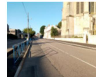
Réfection de 260ml de trottoirs avec mise aux normes des passages piétons, repose de bordures granits de ré-emploi et installation de barrières sur le trottoir devant LA POSTE afin de protéger les piétons.
