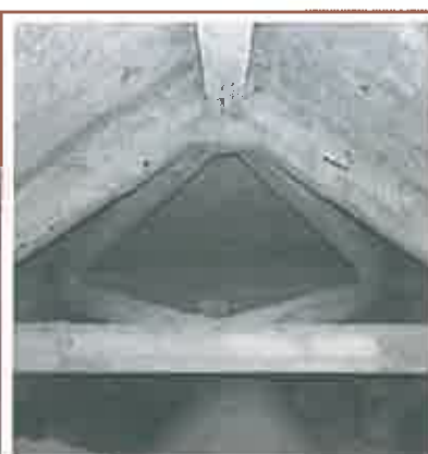
Bas-côté nord, vue intérieure de la charpente en béton
