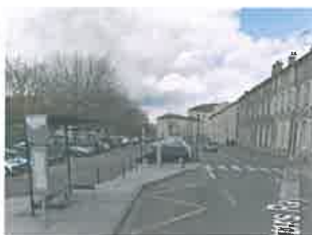
Inclinaison d'accès à l'arrêt de bus à revoir
