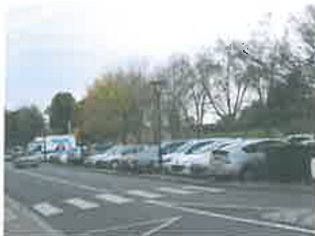
Mauvaise visibilité des circulations piétonnes côté hôpital et le long du parking Absence de surbaissé
